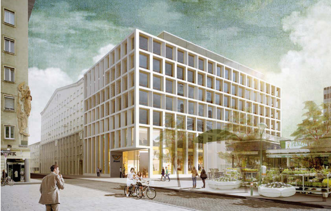
„Post am Rochus“: die gerade entstehende neue Unternehmenszentrale der Post in Wien-Landstraße.
