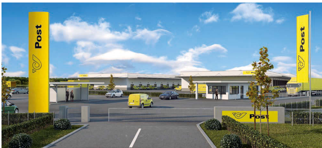
Im September 2014 soll das neue Verteilzentrum in Allhaming seinen Betrieb aufnehmen.
