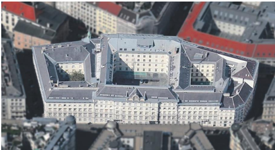
Alte Unternehmenszentrale: Postgasse 1010
